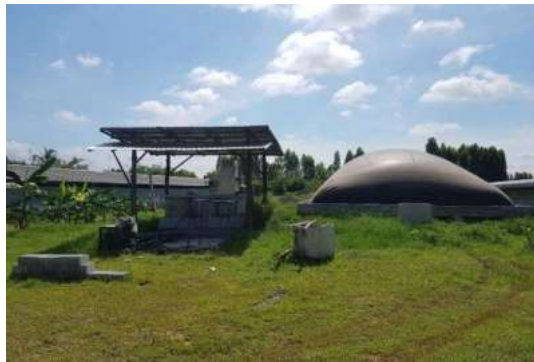
ภาพที่ 3 บ่อหมักมูลสุกร ขนาด 400 ลูกบาศก์เมตร
